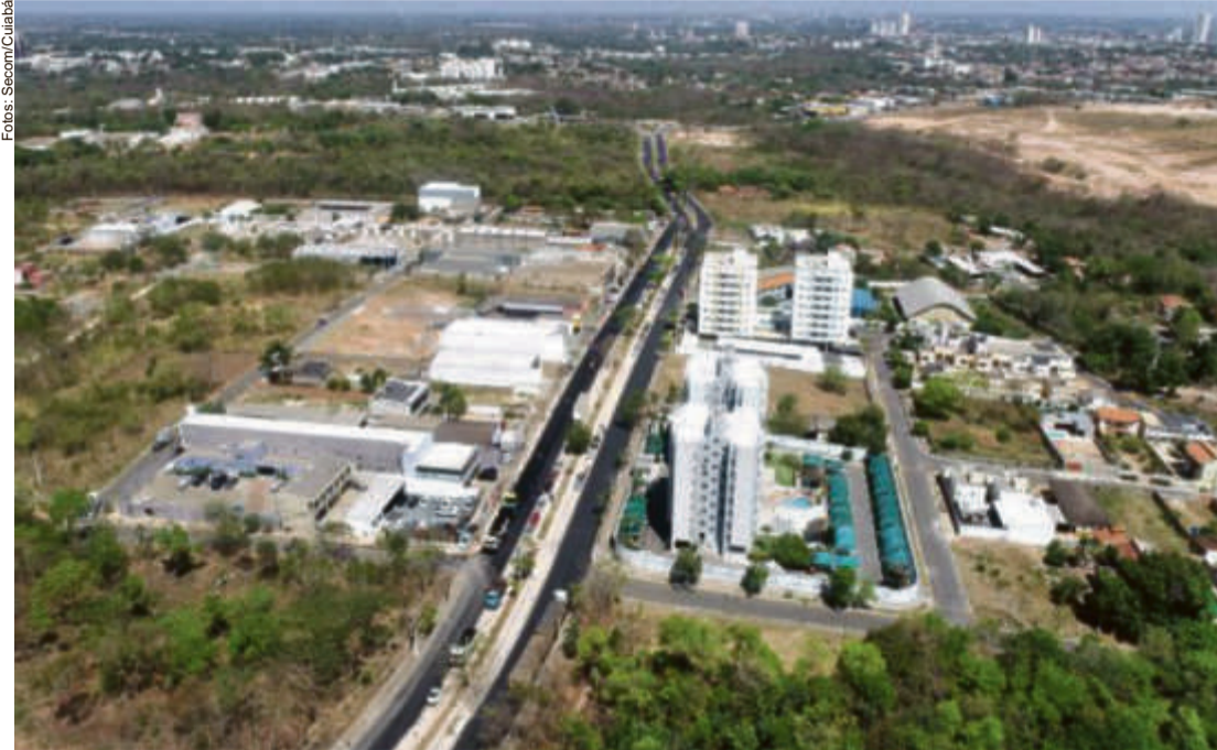
A Avenida Rui Barbosa foi revitalizada e teve seu pavimento restaurado após 20 anos de espera por parte dos moradores da região do Moinho, no Coxipó
