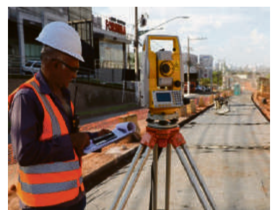
Obras do BRT em Várzea Grande: investigações poderão obrigar o Governo do Estado a suspender execução do projeto e até realizar nova licitação
