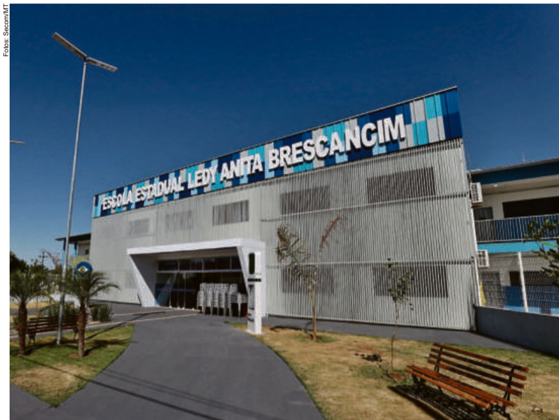
Escola Estadual Ledy Anita Brescancin, em Campo Verde, foi totalmente reformada pelo Governo do Estado dentro do projeto de renovação e reestruturação da rede física educacional pública e Mato Grosso
