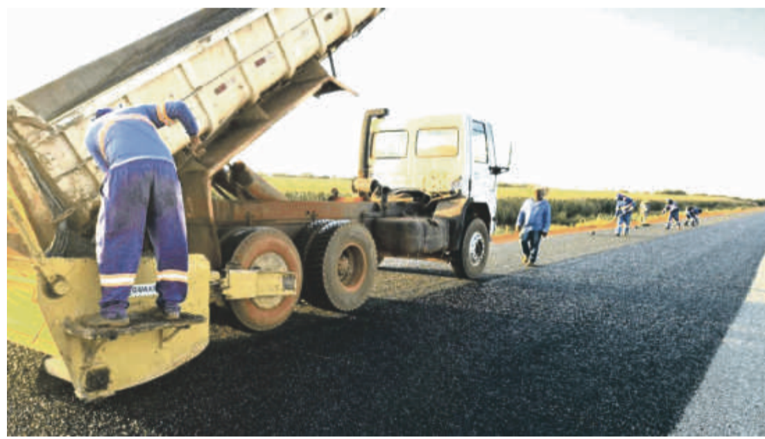
Rodovia MT-240 em Tangará da Serra
