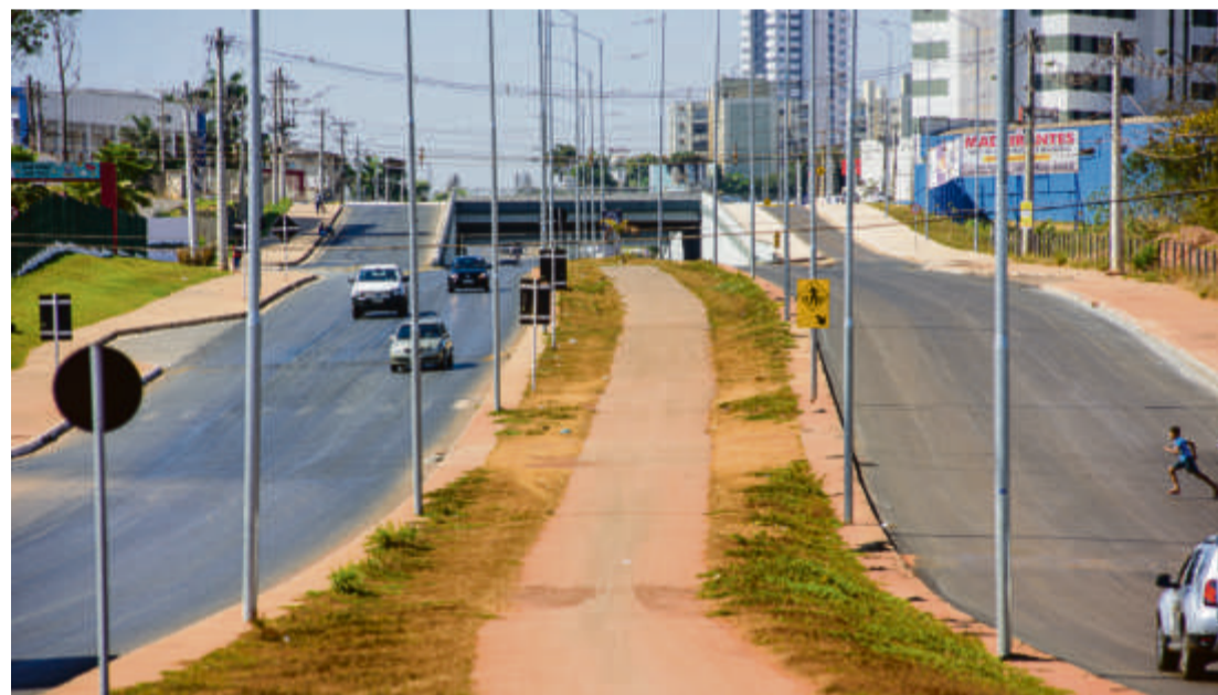
Duplicação da MT-010 estrada da Guia
