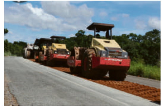
MT-060 Poconé, em obras
