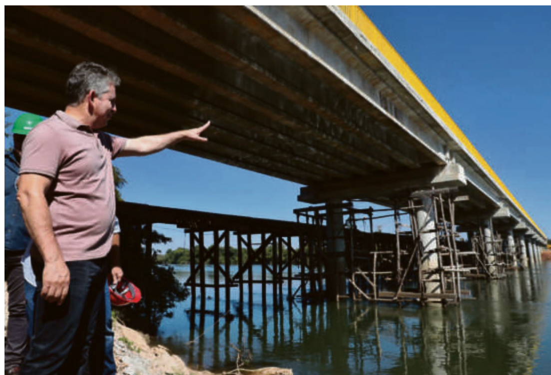
Mauro Mendes visita a Ponte de concreto sobre o rio Arinos
