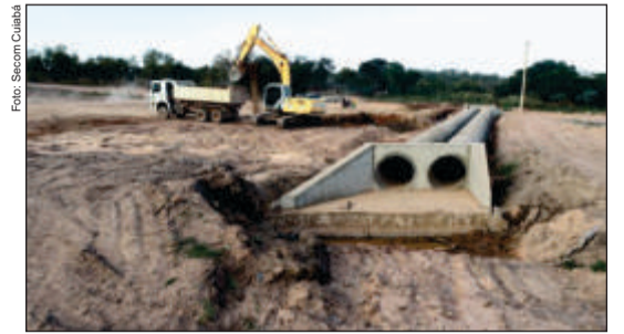
Será feito no local, o lançamento da tubulação, compactação das bases e, por fim, a implantação da pavimentação asfáltica, sob a coordenação da Secretaria Municipal de Obras Públicas (SMOP)
