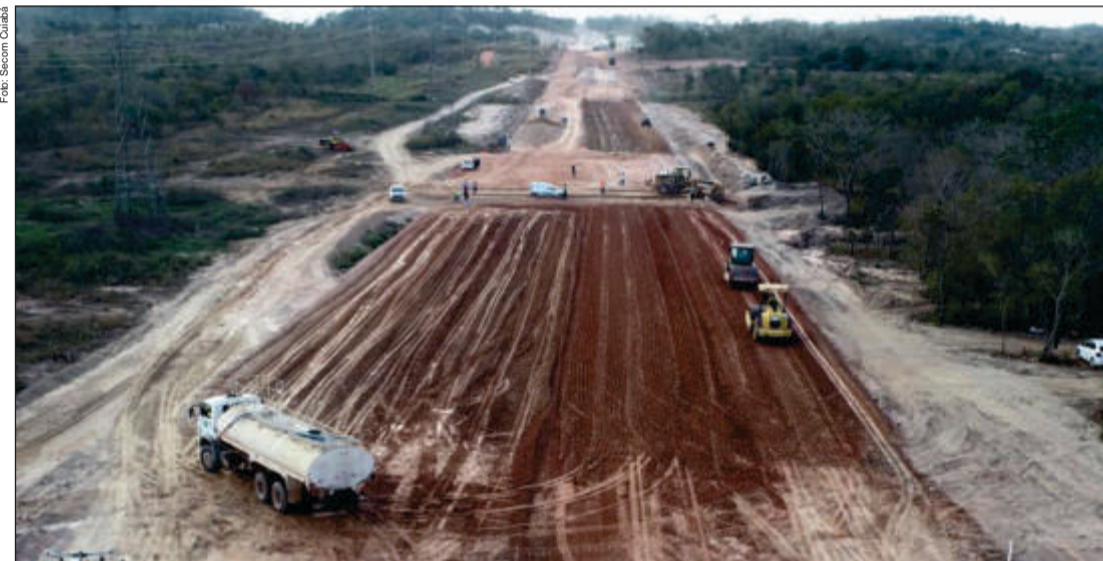
As equipes atuam na etapa de escavação do solo no percurso que abrange cerca de 1,5 km
