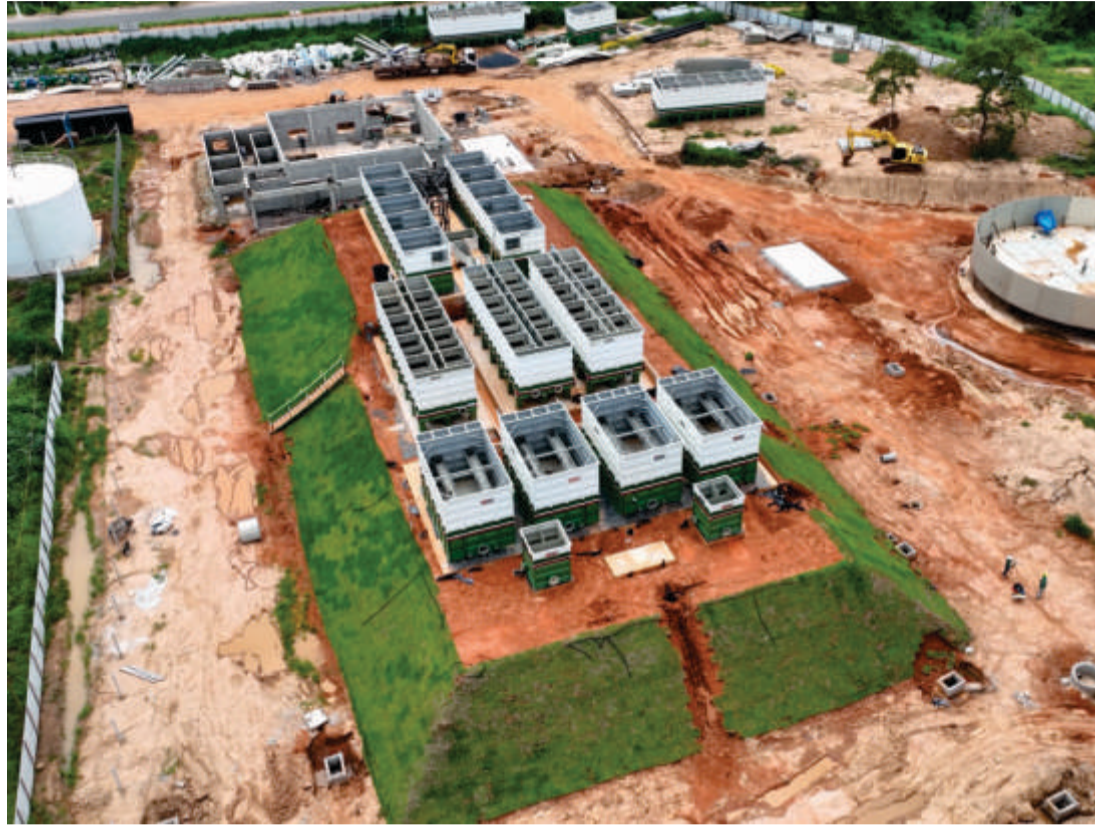
Com capacidade de 250 litros por segundo ou 21,6 milhões de litros por dia, a nova ETA vai abastecer toda uma região de 50 bairros ao longo dos dois lados da Rodovia Mário Andreazza
