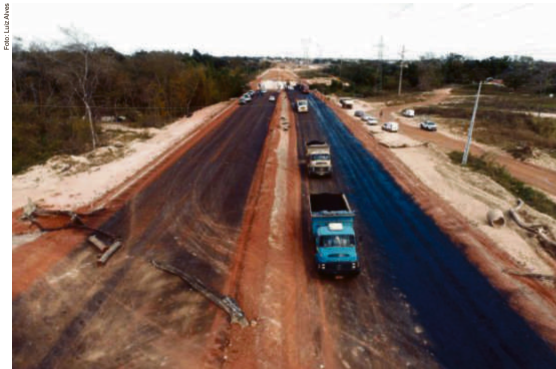
Avenida Contorno Leste recebeu sua primeira camada de pavimentação asfáltica, no trecho situado entre o Rio Coxipó e a Rodovia Emanuel Pinheiro
