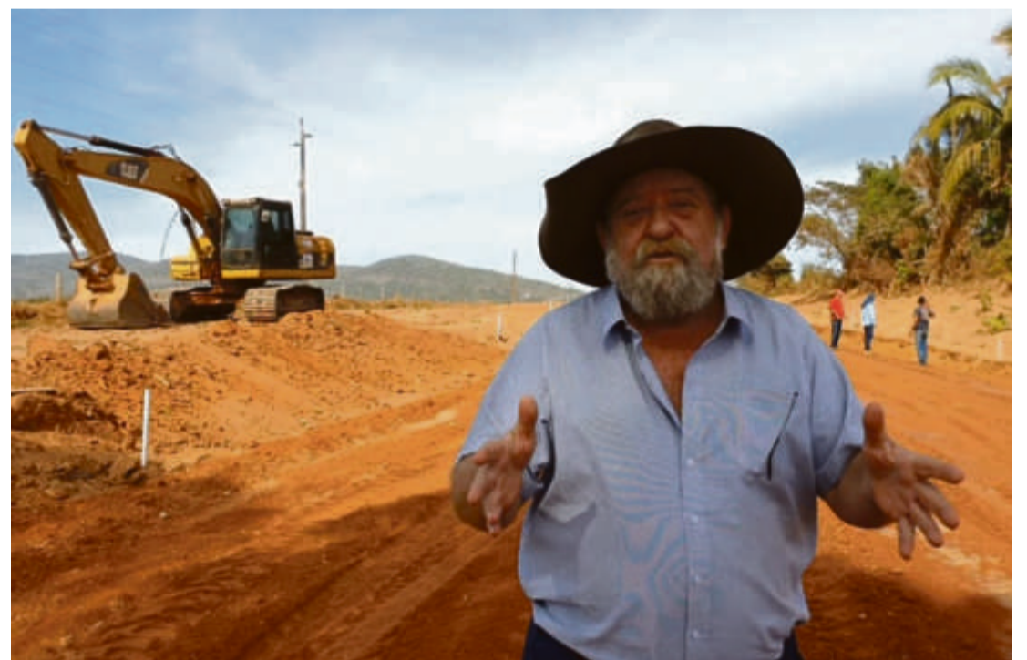
Nelson Barbudo está visitando a região oeste de Mato Grosso. “Passei pela obra do tão sonhado asfalto da Estrada do Matão, a qual fiquei muito feliz em destinar recursos para aquisição de maquinários
