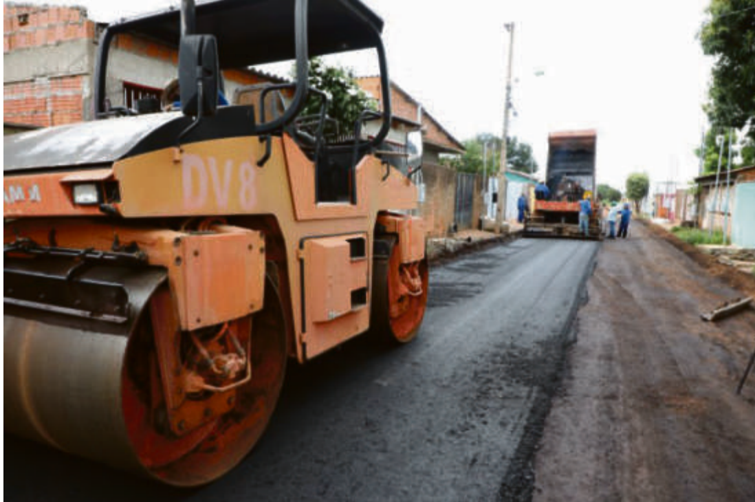
Processo de universalização da pavimentação asfáltica foi implementado desde o primeiro mandato de Emanuel, com o programa Minha Rua Asfaltada
