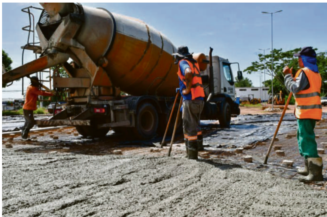
Observando o cronograma de ações, após o calçamento serão executados os trabalhos de jardinagem, pintura e instalação de iluminação de LED
