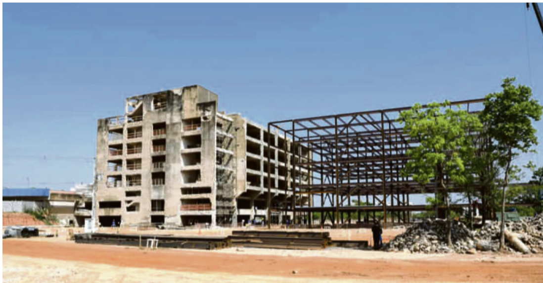
Obra prevê um acréscimo de 23 mil m² à estrutura antiga, sendo que a unidade hospitalar contará com um total de 32 mil m² de área construída
