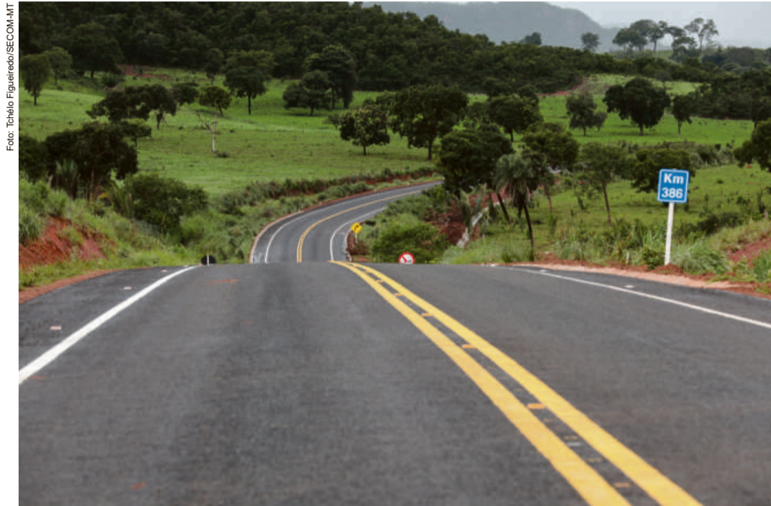
2.500 km de rodovias devem ser concluídos até o final do mandato, além da reforma de escolas e construção e conclusão de hospitais
