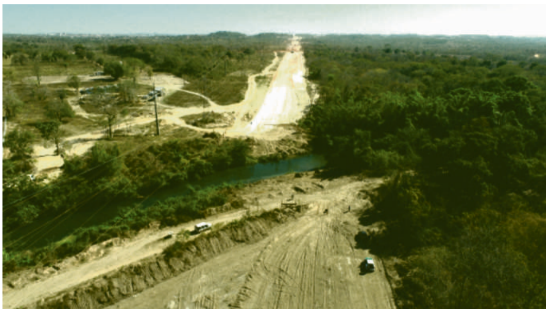
Prefeitura de Cuiabá deu início ao processo de levantamento de uma ponte de concreto sobre o Rio Coxipó
