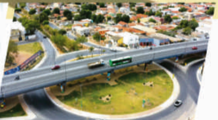
Faixas exclusivas de ônibus e dois novos viadutos.
