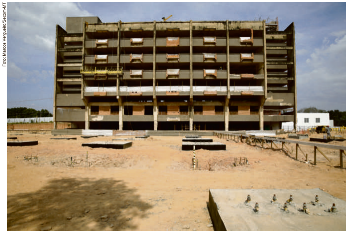
Estão sendo realizados serviços de recuperação estrutural e os serviços seguem em ritmo acelerado, sendo que está em processo de conclusão do pavimento térreo
