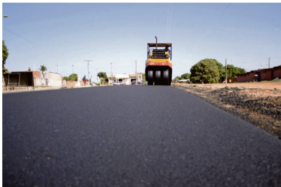
Programa Minha Rua Asfaltada se consolidou como uma das principais medidas da Prefeitura de Cuiabá ao democratizar o benefício da pavimentação
