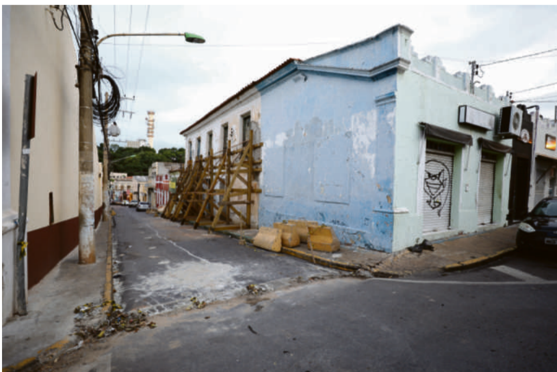
Foi contratada empresa com experiência em restauração de patrimônios tombados, em caráter emergencial, para estabilizar a estrutura do casarão
