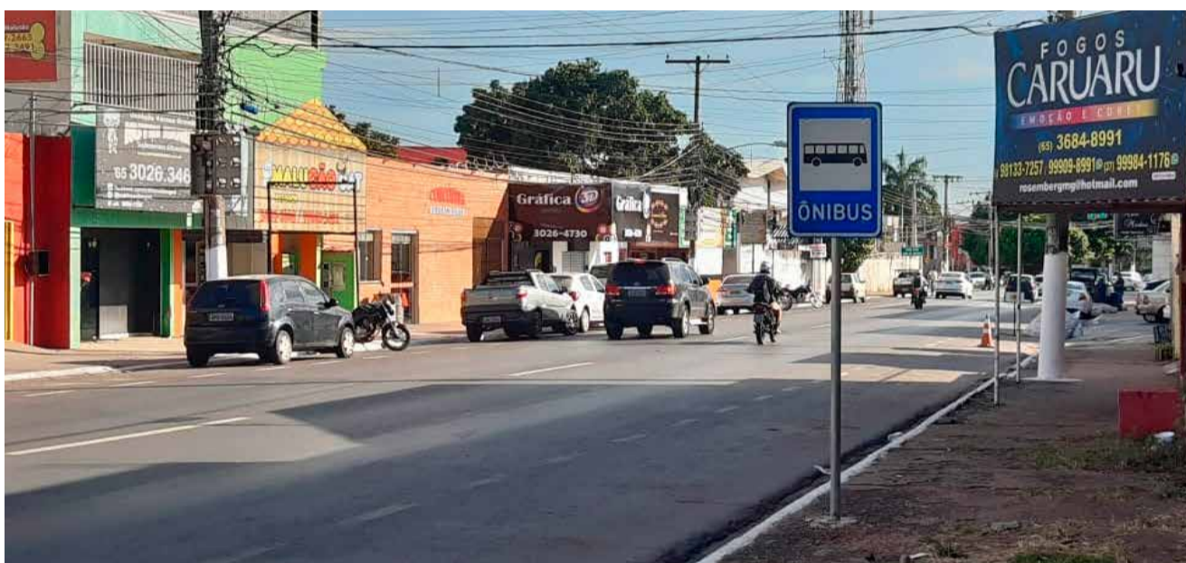
Instalação de novos pontos de ônibus não sai do papel, embora fosse compromisso da União Transportes a instalação de novos abrigos
